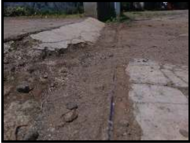
Rel Pagar yang Tertutup Oleh Pasir dan Tanah. Pergeseran Pagar Menjadi Sangat Berat.
