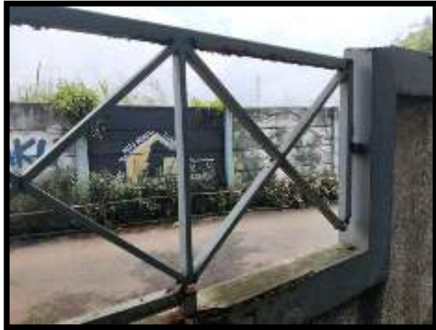
Pagar Gedung yang Sudah Berkarat dan Keropos. Belum Memperoleh Penanganan Sejak Pertama Kali Gedung Dibangun.
